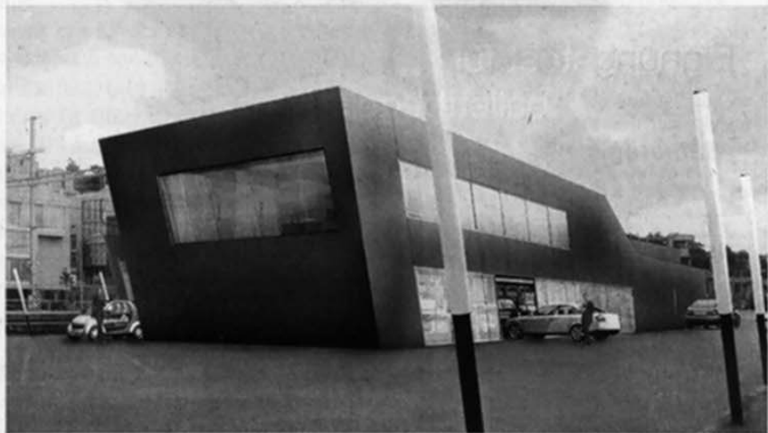
So soll die Waschstrasse an der Einfallsachse Zürichs nach ihrer Fertigstellung im kommenden Oktober aussehen.
